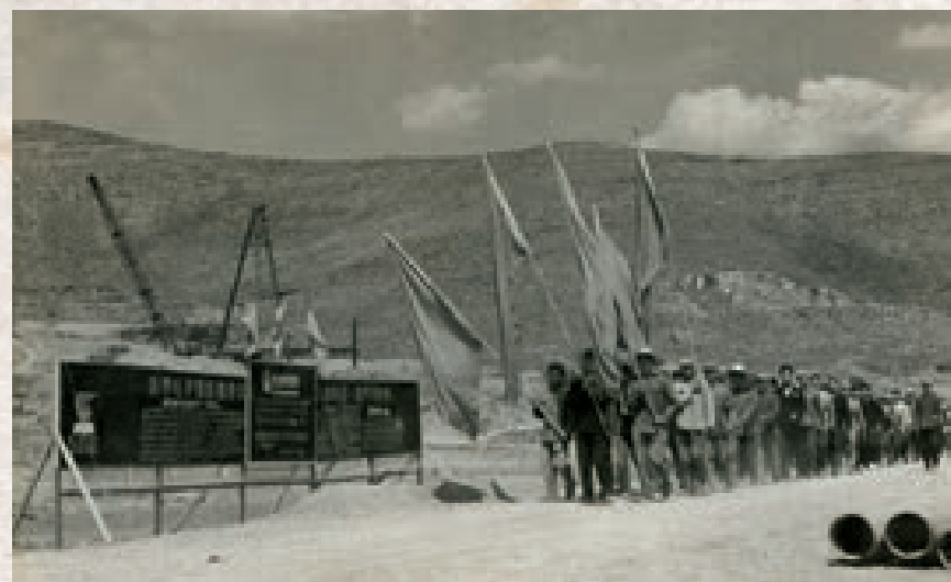
1966 年 4 月，胜利炼油厂破土动工。3000 多名会战职工先生产后生活，革命加拼命，苦干加实干，用不到一年半的时间，建成以大型联合炼油装置为主体的 6 套现代化生产装置及系统配套工程。
